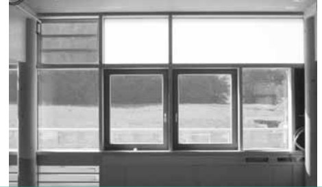
Abb. 9: Fensteraufteilung in den Büros, oben rechts das Feld mit der transluzentente Wärmedämmung
