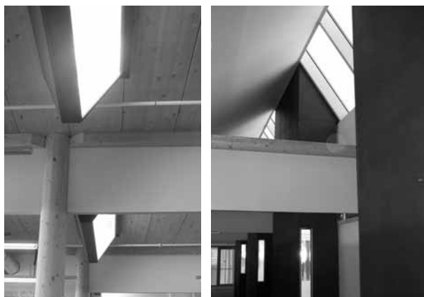
Abb. 10 a/b: Verspiegelter Lichtschart in der Werkstatt (links) „Lichtkamine“ im Obergeschoss (rechts)
