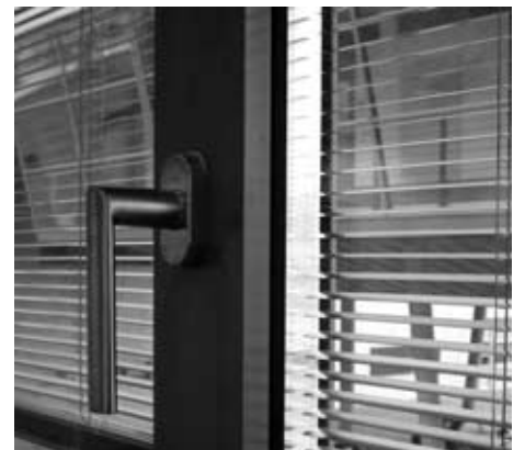
Abb. 10: Sonnen- und Blendschutz im Scheibenzwischenraum
