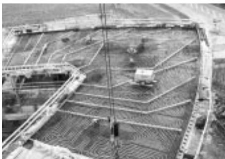
Abb. 5: Verlegung der Rohrregister zur Betonkerntemperierung und der Zuluftkanäle in den Geschossdecken.
