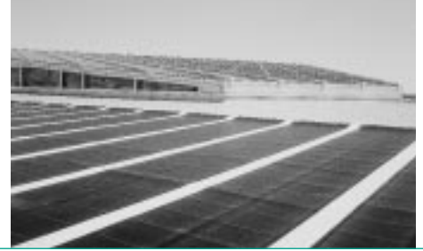
Abb. 4: Dachbahn mit amorphen Solarzellen
