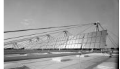
Abb. 5: Das Dachtragwerk mit den Solarkollektoren
