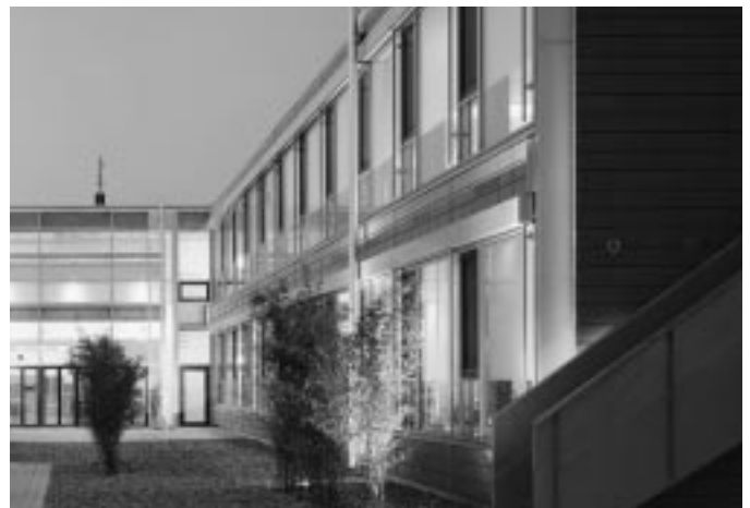
Abb. 10: Bürofassaden mit Sichtfenster, lichtstreuenden Gläsern und Vakuumpaneelen
