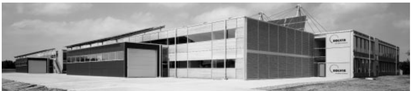
Abb.7: Das Gebäude wurde modular aus Holzrahmenbauelementen zusammengefügt.
