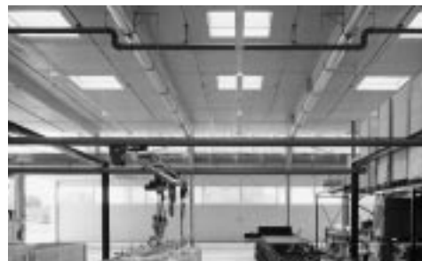
Abb. 4: Blick in die Produktionshalle mit Dachoberlichtern und Lüftungskanälen. Das außenliegende Tragwerk ermöglicht trotz großer Spannweite eine schlanke stützfreie Holzkonstruktion.
