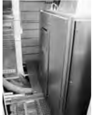
Abb. 6: Die Abluftwärmepumpe
