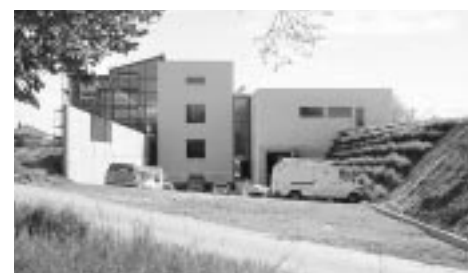
Bild 4: Nordansicht mit LKW-Andienung
