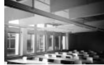
Abb. 8: Seminarraum mit Akustiksegeln
