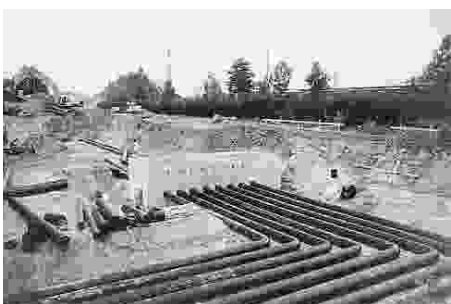
Abb. 6: Rohrsystem und Ansaugbauwerk des Luft-/Erdregisters in der Bauphase
