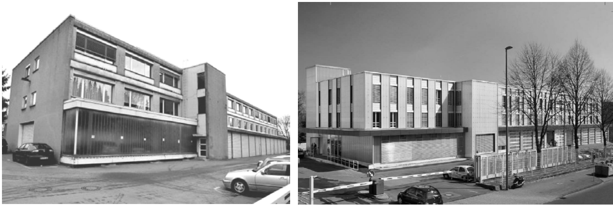
Bild 1: Ansicht der Süd- und Westseiten des Gebäudes vor (links, Quelle: ACMS) und nach der Sanierung (rechts, Quelle: T. Riehle)
