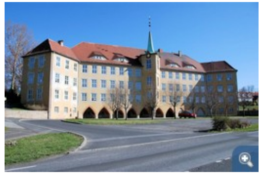
Die Schule in Olbersdorf vor der Sanierung: Mit der Sanierung soll das Gebäude aus der Weimarer Zeit den sogenannten 3-Liter-Haus-Standard erreichen. © Gemeinde Olbersdorf
