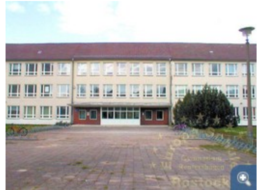
Eingangsbereich der bestehenden Schule im unsanierten Zustand © Schulverwaltung Gymnasium Reutershagen
