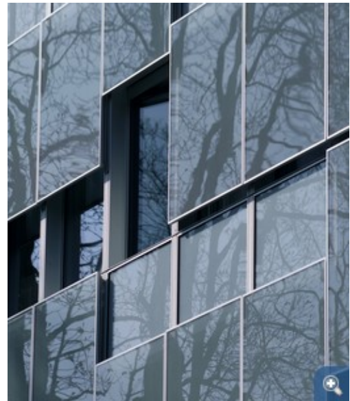
Detail der neuen Fassade mit beweglichen Brüstungselementen aus Glas-Streckmetall als raumweise steuerbarer Sonnenschutz. © RKW Architektur + Städtebau. Foto: Carsten Costard
