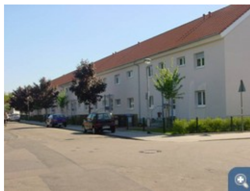
Gebäude nach der Sanierung © GBG Mannheimer Wohnungsbaugesellschaft mbH
