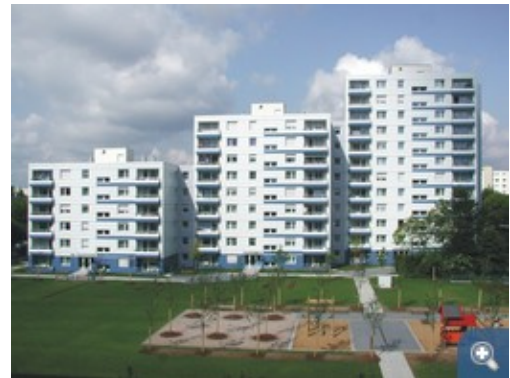
Saniert ist die Hochhauswohnanlage kaum wiederzuerkennen. Neben den energetischen Vorteilen konnte auch ein erheblicher ästhetischer Zugewinn erzielt werden. © Volkswohnung GmbH
