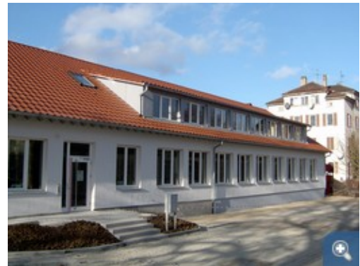
Ostansicht des sanierten Gebäudes auf dem Gelände der ehemaligen Thiepvalkaserne © ebök, Tübingen
