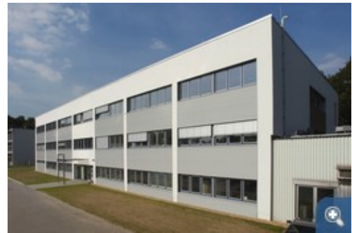
Die Fassade der modellhaft sanierten Forschungseinrichtung. © FZ Jülich
