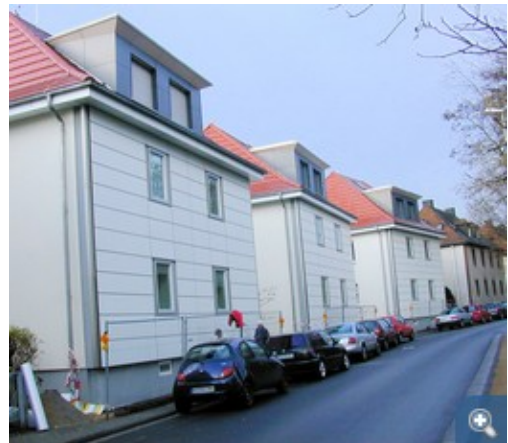
Die drei Zweifamilienhäuser in der Wilhelmstraße in Hofheim (Taunus) kurz nach Fertigstellung der Sanierung – und im Vergleich dazu ... © IWU, Institut Wohnen und Umwelt GmbH
