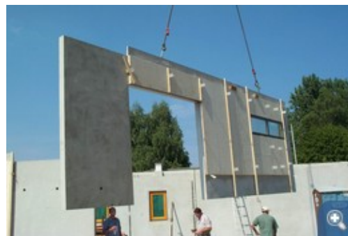
Der Einsatz von VIP am Bau.
