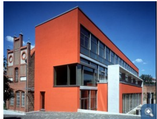
Die verglaste Südfassade des ZUB Kassel ermöglicht eine optimalen Tageslichtnutzung. © ZUB Kassel
