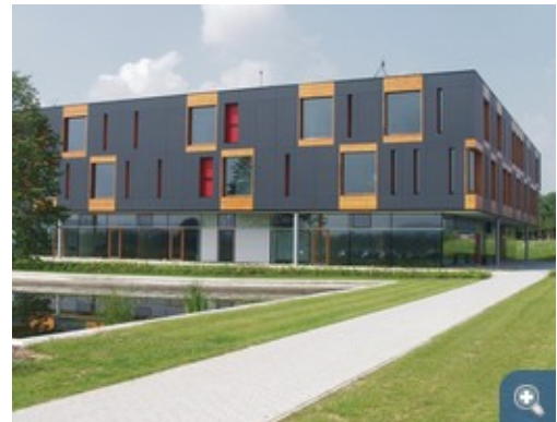
Das Verwaltungsgebäude der Firma Pollmeier wurde 2002 mit dem Deutschen Fassadenpreis ausgezeichnet. © Fa. Pollmeier
