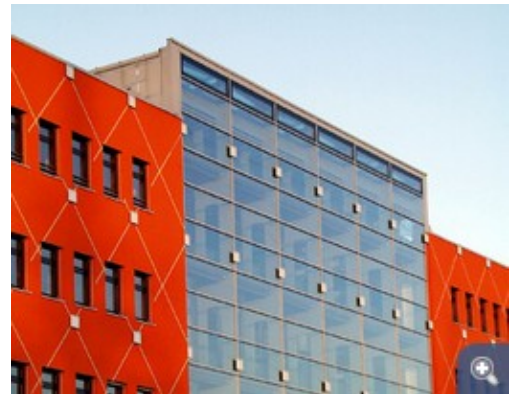
Das Atrium spielt nicht nur im Energiekonzept eine wichtige Rolle, sondern setzt auch einen gestalterischen Akzent. © fbta, Universität Karlsruhe
