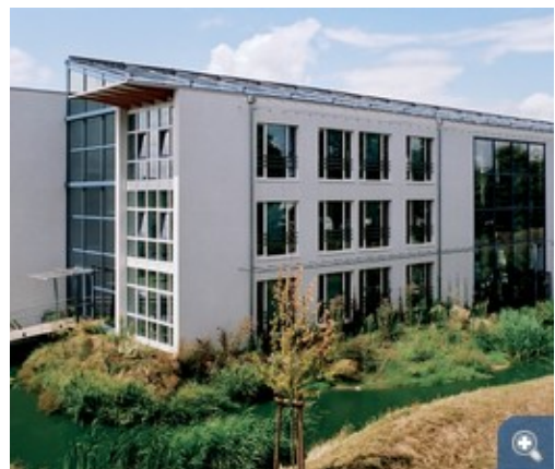
Das Gebäude der SurTec GmbH von Süden: Zu sehen ist der Verwaltungstrakt. Dahinter schließt sich das Atrium an, das die Verwaltung mit dem Chemielabor verbindet.
