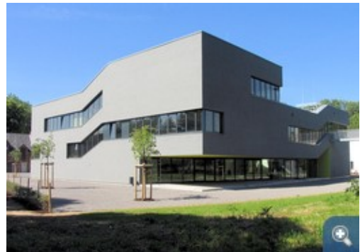
Das Science College kurz nach der feierlichen Inbetriebnahme des Gebäudes am 27. Juni 2009 © Science College Overbach. Architektur: Hahn Helten Architekten
