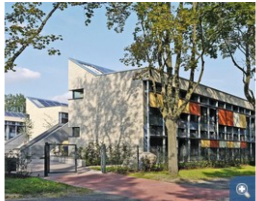
Ansicht der neuen Plusenergie-Schule von der Goethestraße. Auf einen Blick erkennt man den Fokus auf Tageslichtnutzung, Sonnen- und Blendschutz sowie die Photovoltaik-Anlage. Doch das Gebäudekonzept bietet mehr ... © IBUS Architekten und Ingenieure, Berlin/Bremen
