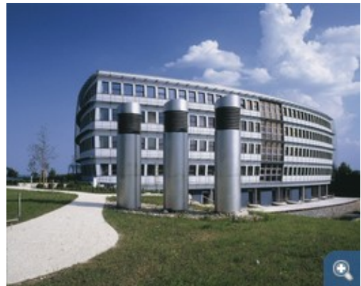
Das neue Energon Gebäude in der Gesamtansicht. Im Vordergrund sind die Ansaugtürme für die Lüftungsanlage zu sehen. © Software AG Stiftung
