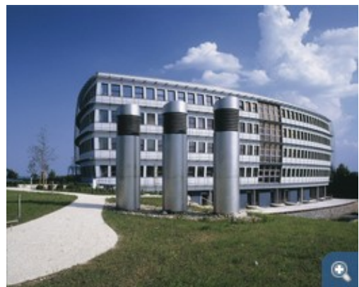
Das neue Energon Gebäude in der Gesamtansicht. Im Vordergrund sind die Ansaugtürme für die Lüftungsanlage zu sehen. © Software AG Stiftung
