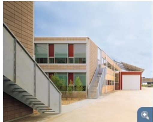
In dem neuen Gebäudekomplex der Solvis GmbH sind Produktions- und Verwaltungsbauten vereint. © Solvis GmbH, C.Richters
