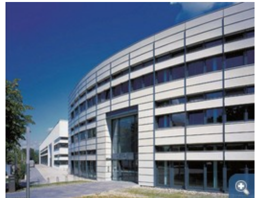
Der Neubau des Institutsgebäudes wurde 2001 bezogen. Zu sehen ist der Kopfbau mit Haupteingangsbereich. © Fraunhofer ISE
